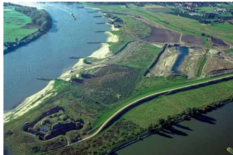
Foto 2. Luchtfoto van de Klompenwaard kort na de start van de graafwerkzaamheden (16 oktober 1999). Foto gemaakt vanuit het oosten, linksonder is Fort Pannerden te zien
